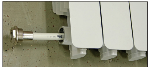
Рис.21 Установка удлинителя потока
