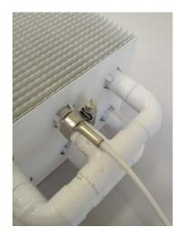
3.4 Затянутый термометр необходимо опломбировать через отверстие в головке хомута.
