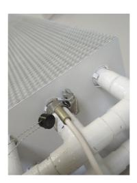
3.5 После пломбирования термометра устанавливаем кожух конвектора (в случае его демонтажа) на место. На подготовленный ранее адаптер навешиваем распределитель тепла и устанавливаем защитную пломбу входящую в комплект поставки.
